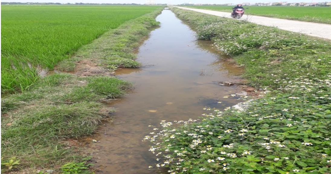
Tuyến mương hiện có tiếp giáp phía Đông dự án
