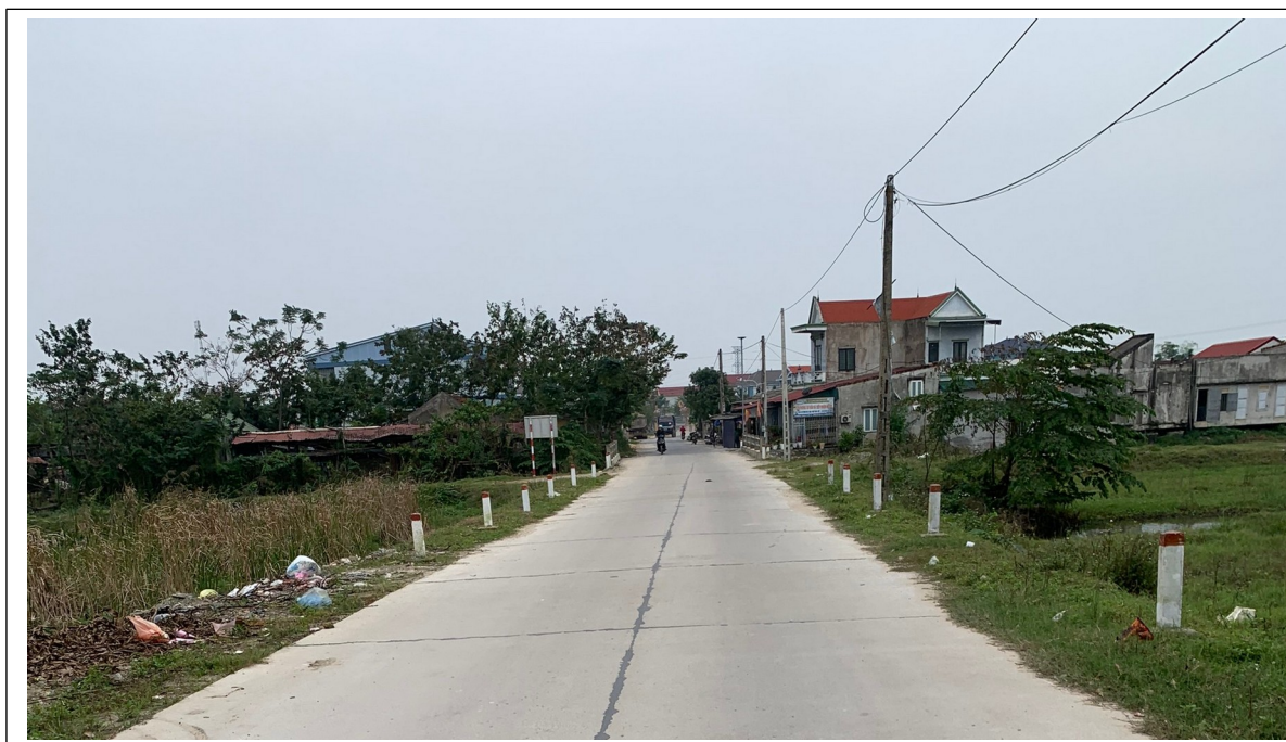
Hình 1. 2. Hiện trạng tuyến đường giáp phía Bắc khu vực Dự án 1.1.4. Hiện trạng quản lý và hiện trạng sử dụng đất của dự án - Hiện trạng sử dụng đất
