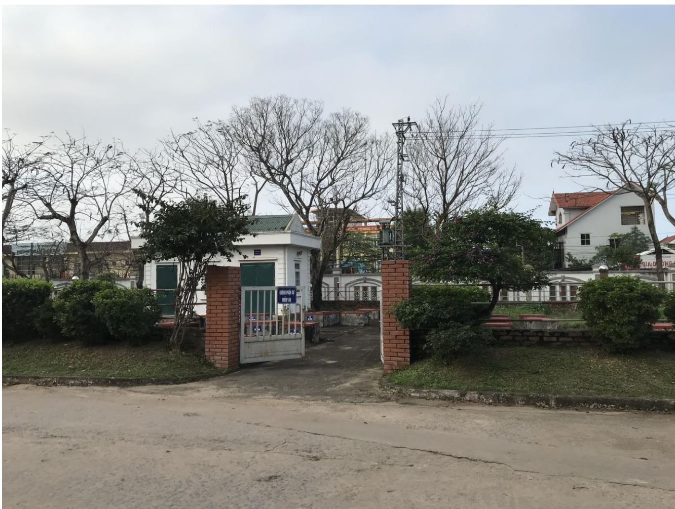
Hình 3.1: Trạm xử lý nước thải của bệnh viện
