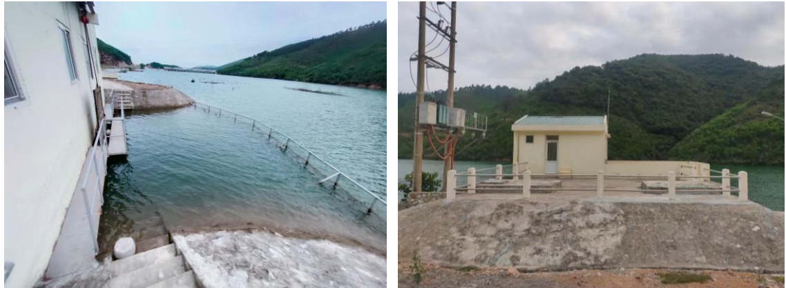
Hình 1.2. Trạm thu nước thô cấp I
