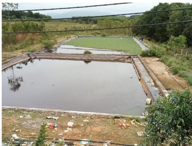
Hình 3.3. Hệ thống xử lý nước thải
