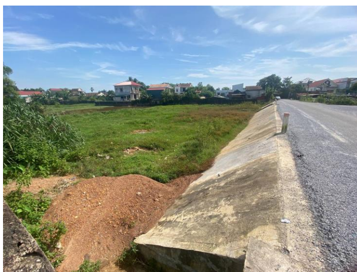
Hình 4. Hiện trạng mái taluy bên đường
