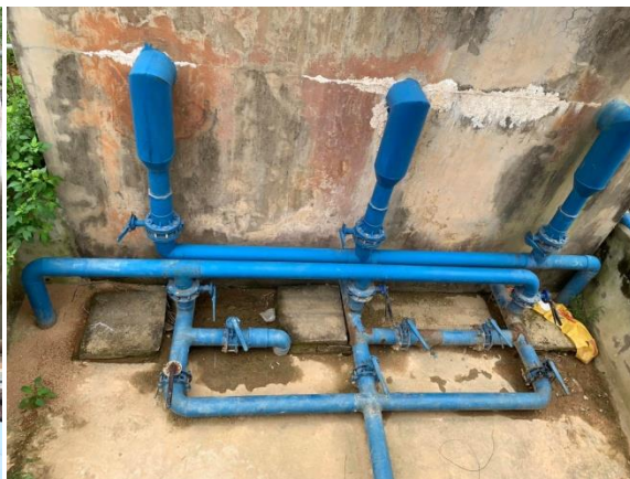
Bể chứa nước sạch
