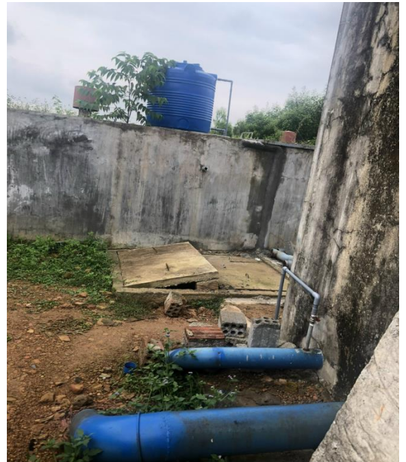
Bể chứa nước sạch
