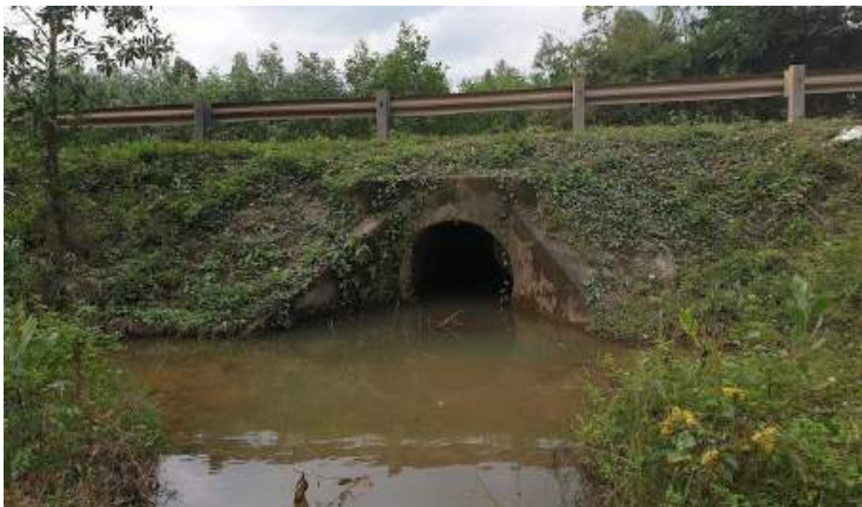
Hình 1.4. Cống D1500 qua đường Hồ Chí Minh
