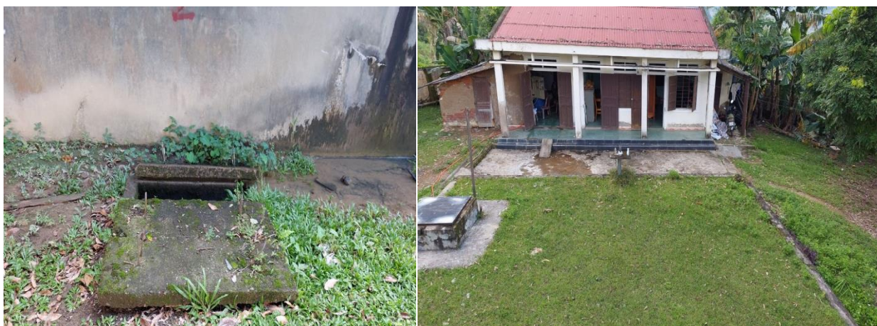
Hình 3. 2. Hình ảnh mương thoát và hồ ga tại cơ sở
