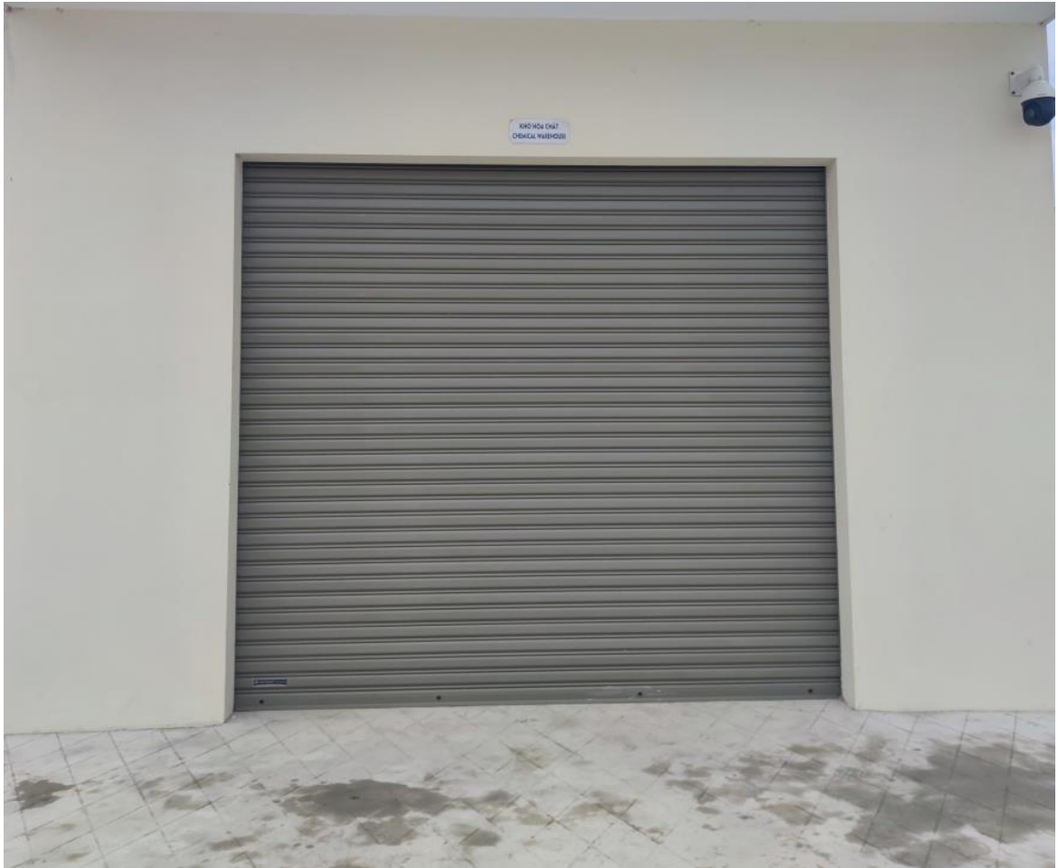
Hình 6: Kho lưu giữ chất thải nguy hại của Trang trại điện gió BT1
