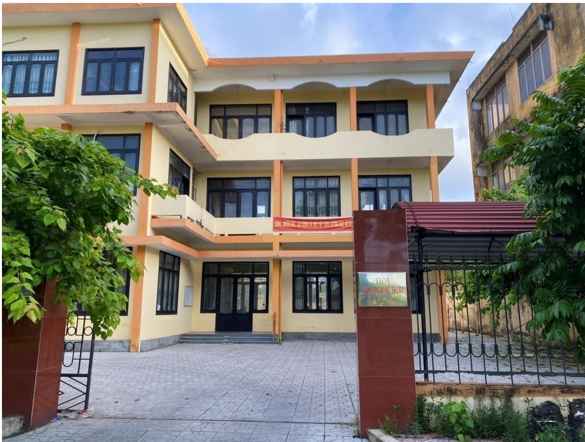
Hình 8. Công trình Trụ sở Hội văn học nghệ thuật tỉnh Quảng Bình giáp phía Tây
