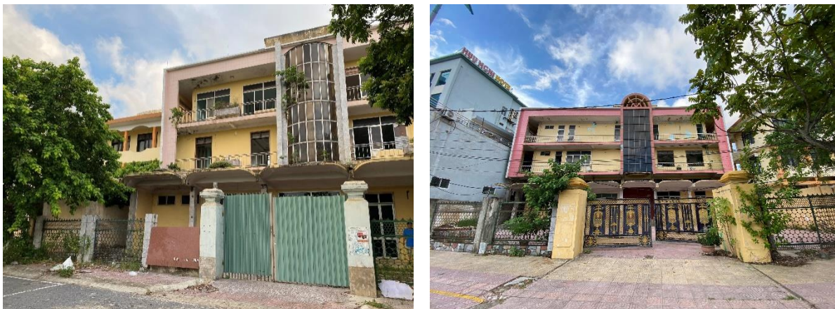
Hình 24. Hình ảnh công trình cũ sẽ được phá bỏ hoàn toàn
