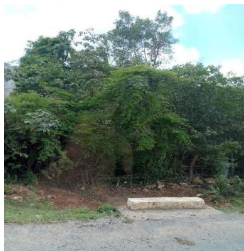
Hình 1.4. Cống thoát nước qua đường.
