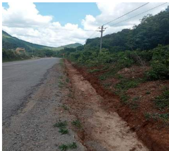
Hình 1.3. Mương thoát nước nước mưa chảy tràn dọc đường QL 9B.
