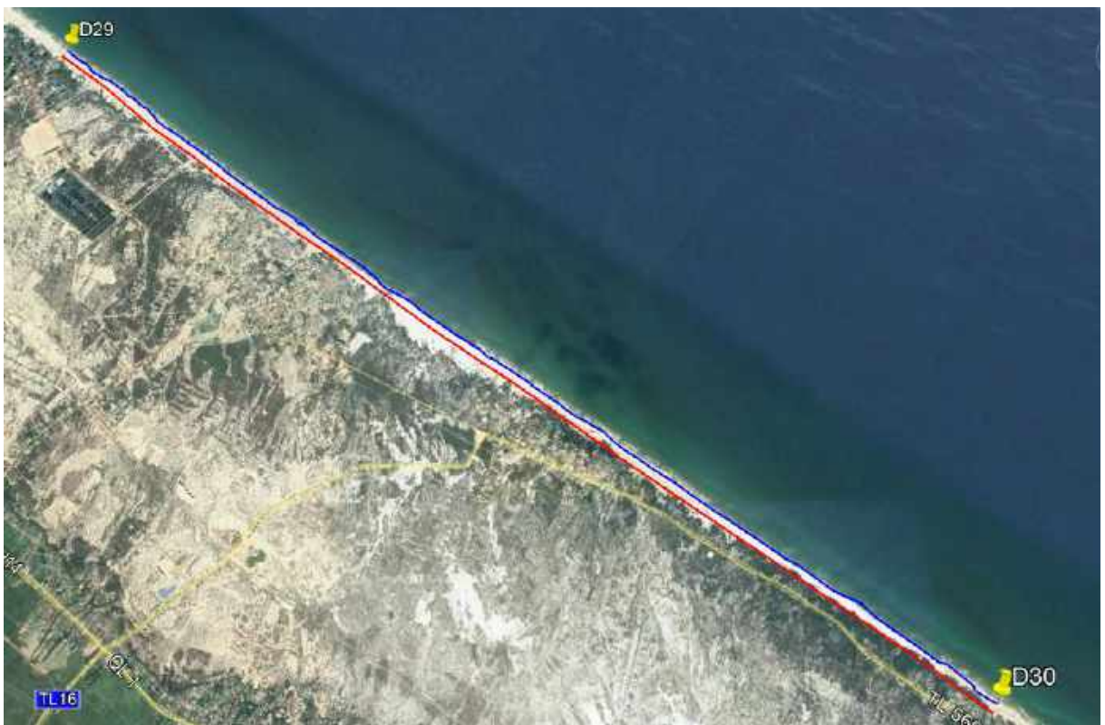
Hình 2.20 Ranh giới hành lang bảo vệ bờ biển KV20 xã Ngư Thủy Bắc
