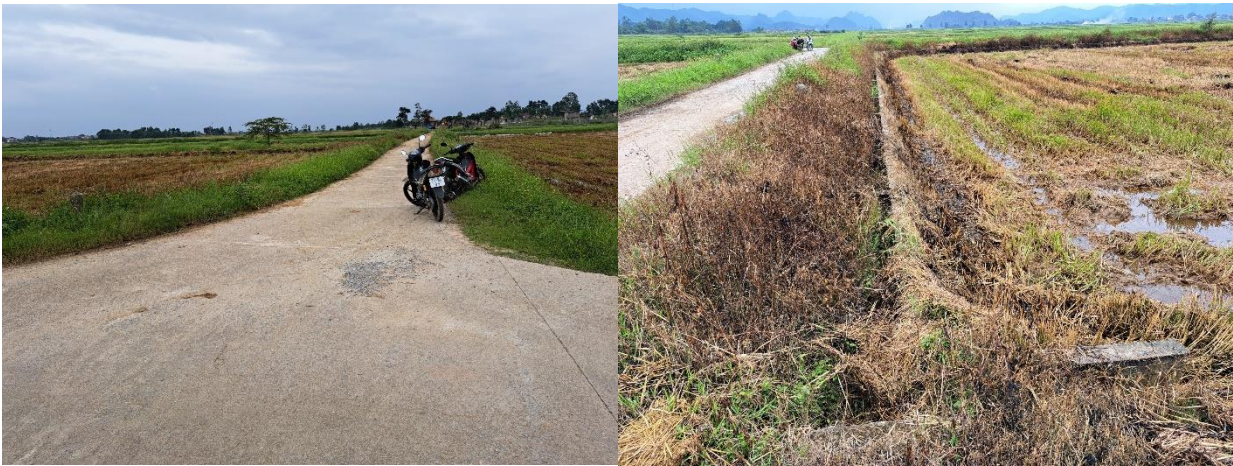
Hình 2: Hiện trạng Tuyến Nhánh
