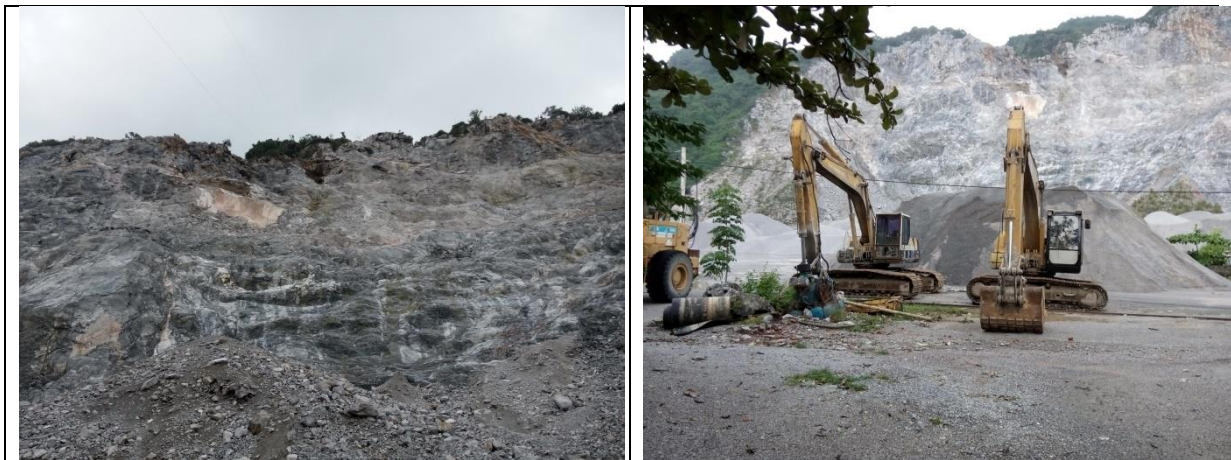
Hình 1.2. Hiện trạng khu đất Dự án
