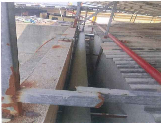
Đường ống thu bụi, khí thải từ phòng sấy về hệ thống xử lý
