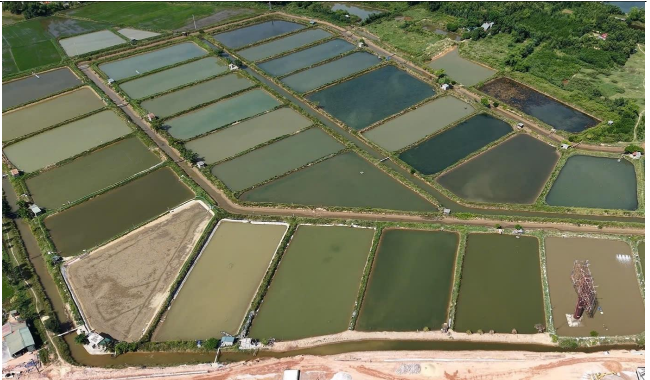
Hình 1.4. Hiện trạng đất ruộng lúa, ao hồ khu vực quy hoạch.
