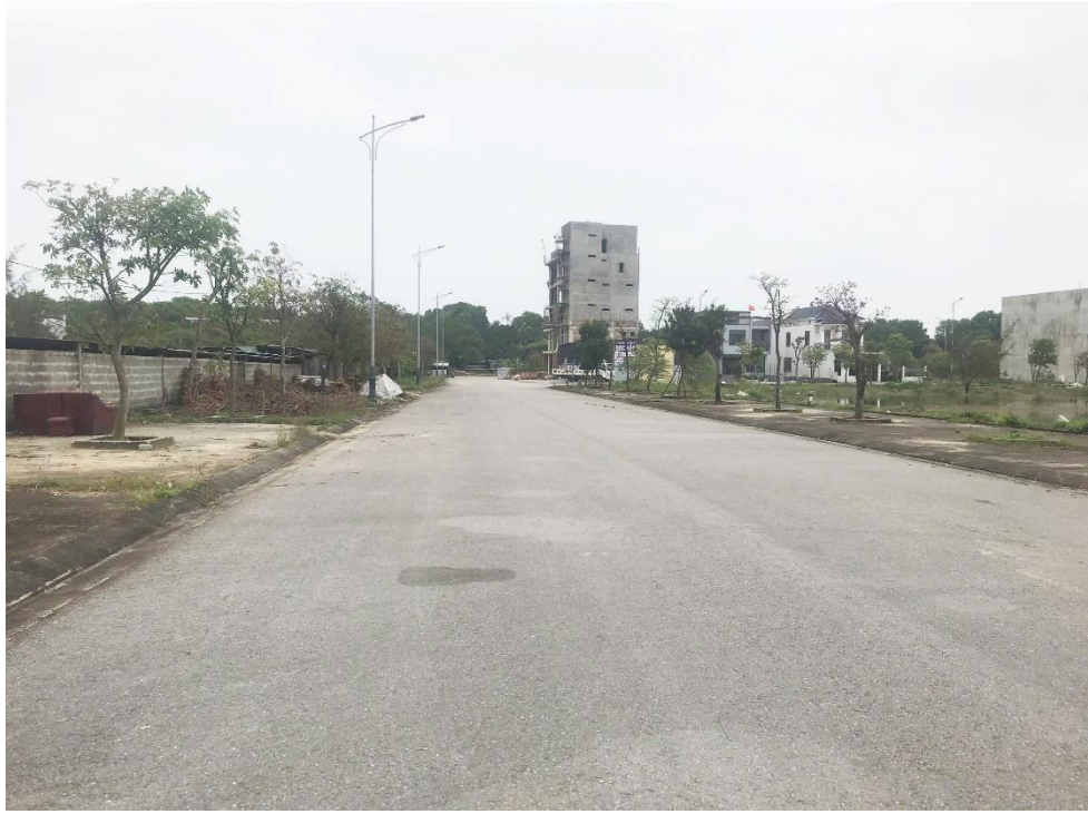
Tuyến đường 22,5m nằm giáp phía Nam khu đất
