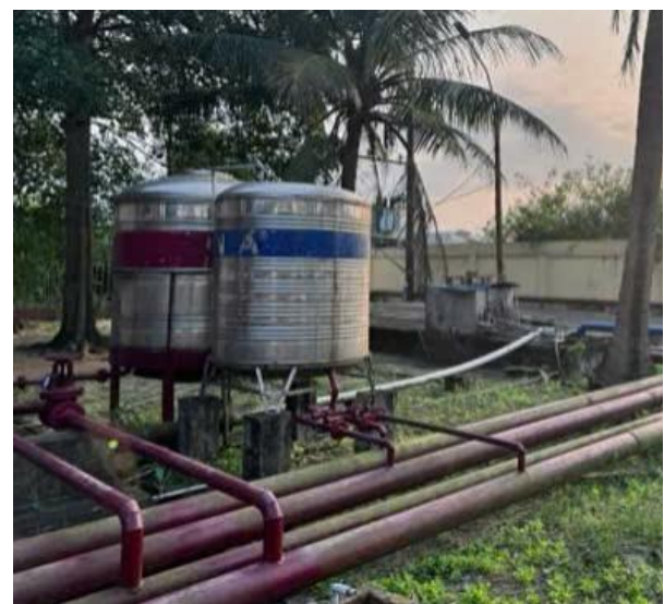
Hình 1.8. Trạm bơm nước chữa cháy
