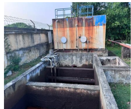
Hình 3.8. Hình ảnh bể xử lý nước thải nhiễm dầu của cơ sở Thông số kỹ thuật của hệ thống XLNT như sau:
