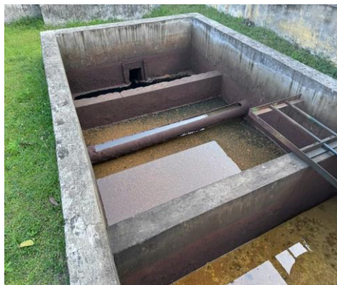
Hình 3.8. Hình ảnh bể xử lý nước thải nhiễm dầu của cơ sở Thông số kỹ thuật của hệ thống XLNT như sau:
