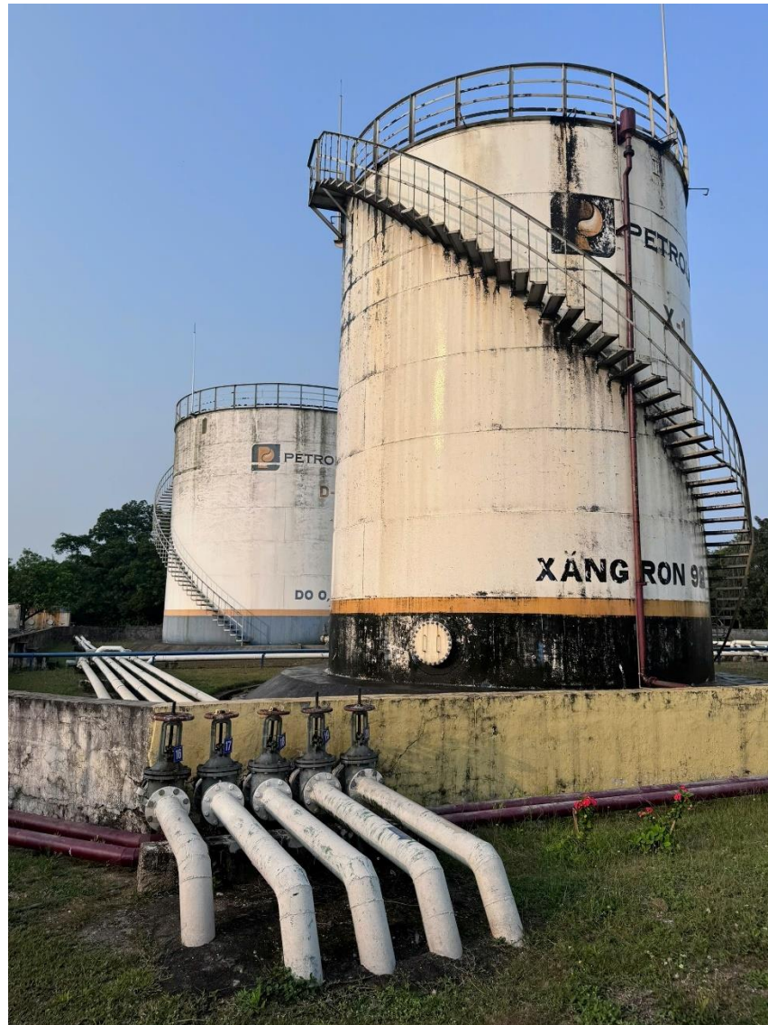
Hình 1.5. Đê ngăn cháy
