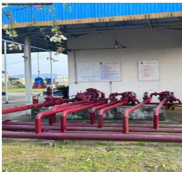
Hình 1.8. Trạm bơm nước chữa cháy
