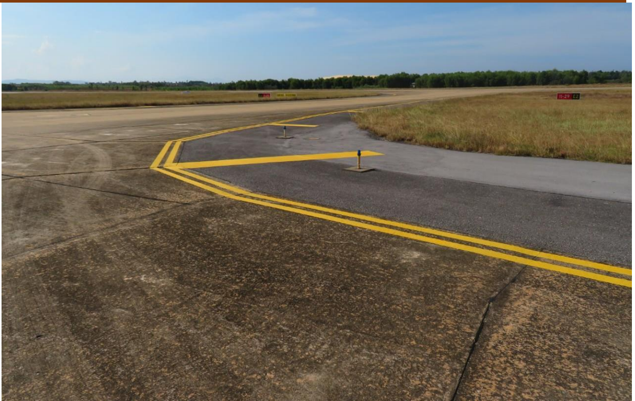
Hình 1.8. Hệ thống đèn lè đường lăn
