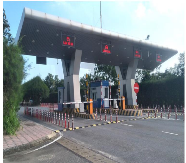
Trạm thu phí
