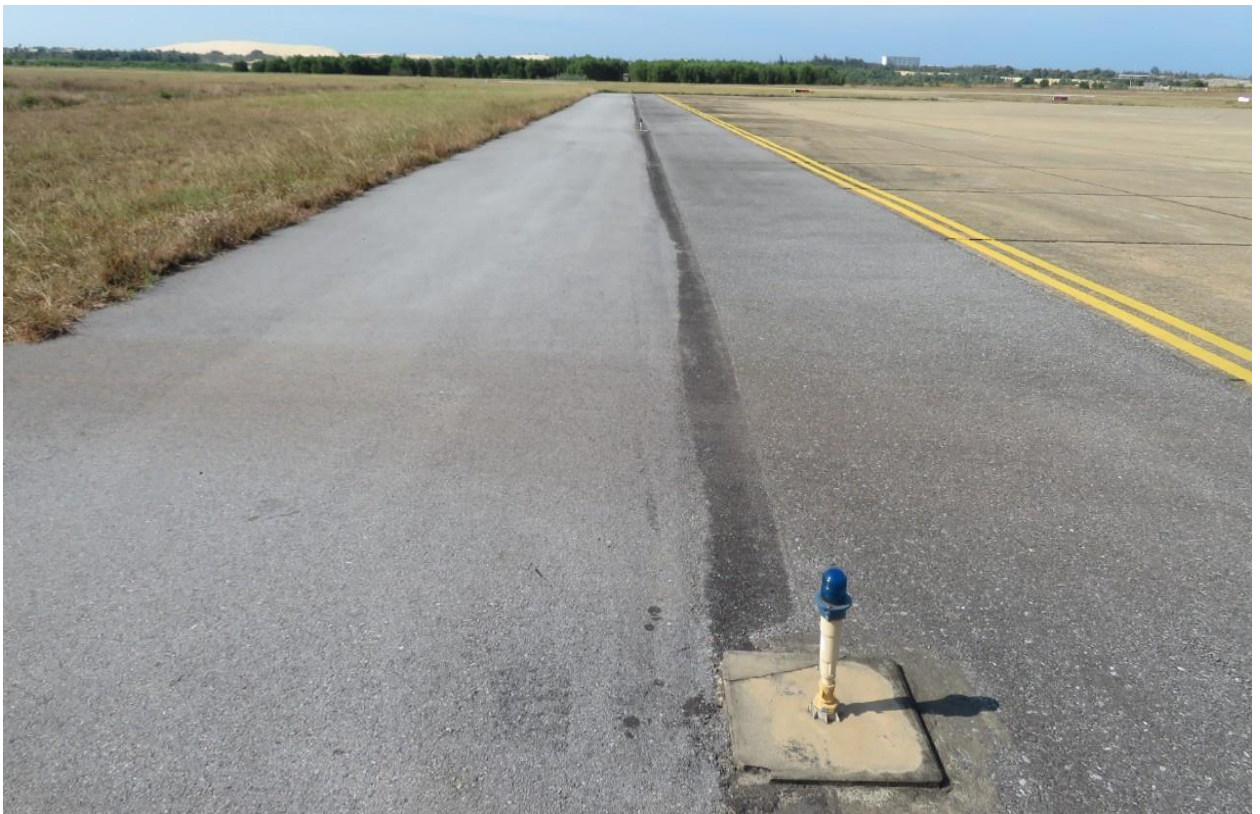
Hình 1.9. Hệ thống đèn lè sân đỗ.
