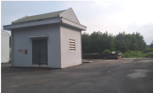
Trạm bơm và bể nước
