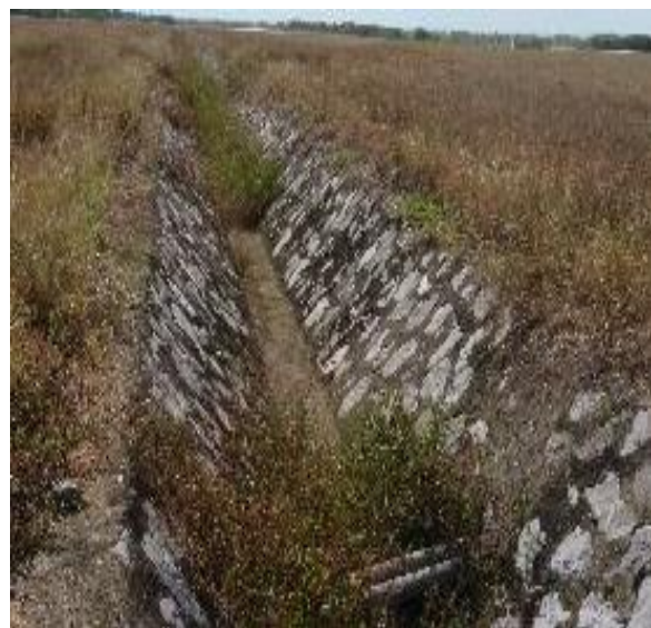
Mương thoát nước đá xây dọc đường cất hạ cánh
