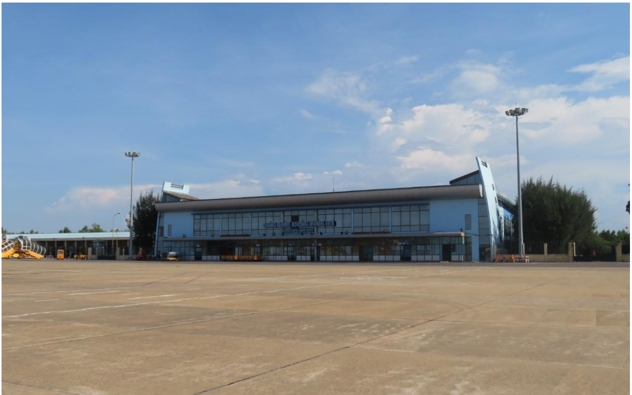
Hình 1.7. Hệ thống 3 cột đèn chiếu sáng trước nhà ga hành khách
