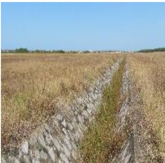
Mương thoát nước đá xây dọc đường cất hạ cánh
