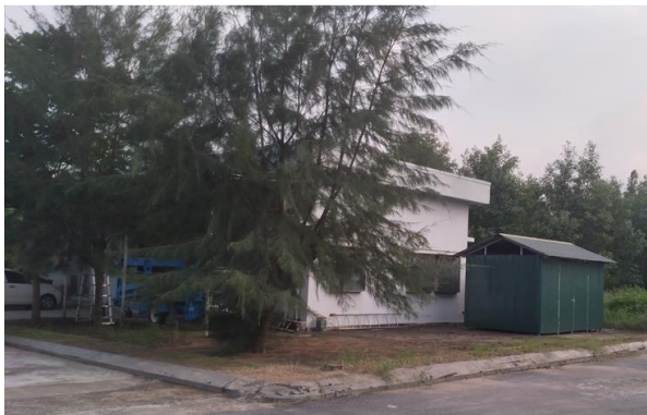
Trạm điện nguồn
