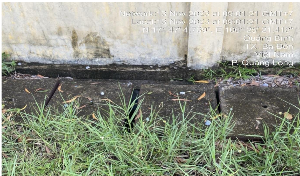
Hình 3.5. Hố ga tiếp nhận nước mưa của cơ sở đấu nối với khe nước cách cơ sở 70m về phía Đông Bắc
