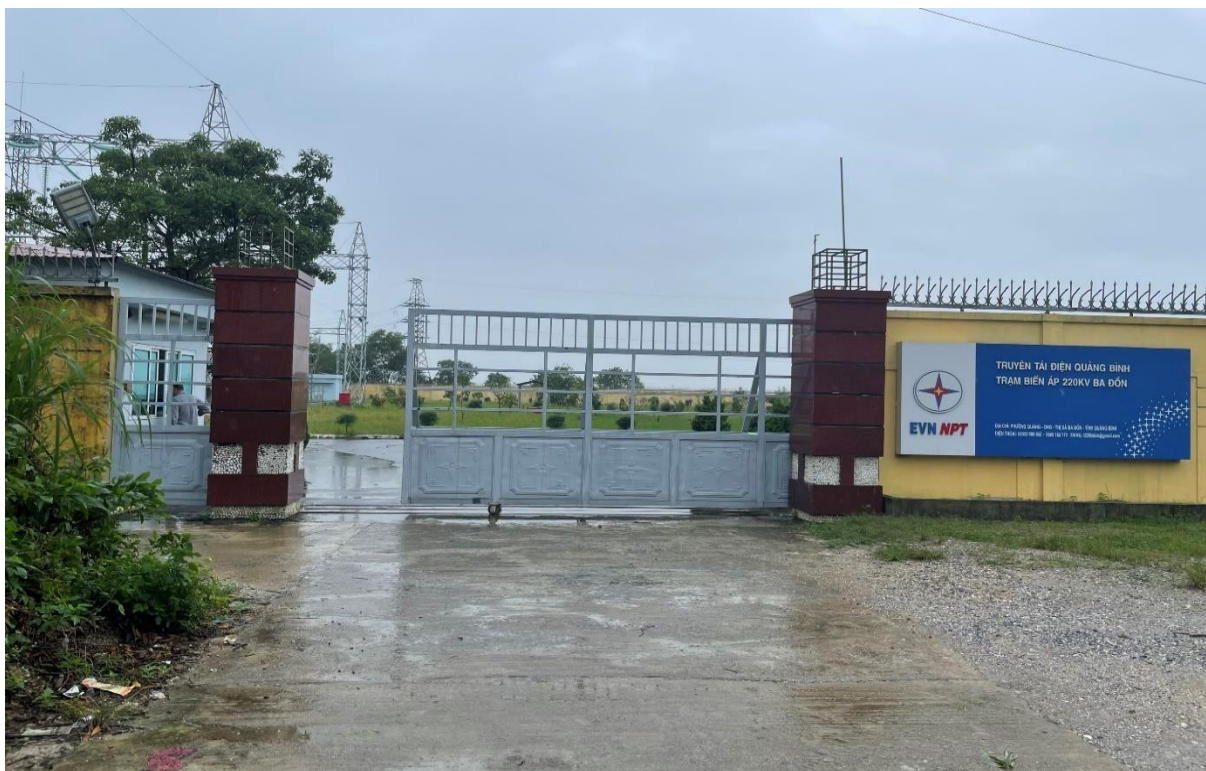
Hình 1.3. Cơ sở Trạm biến áp 220kV Ba Đồn
