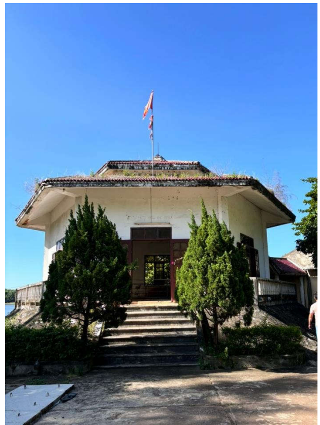
Hình 3: Nhà trạm tại khu vực Bàu Tró
