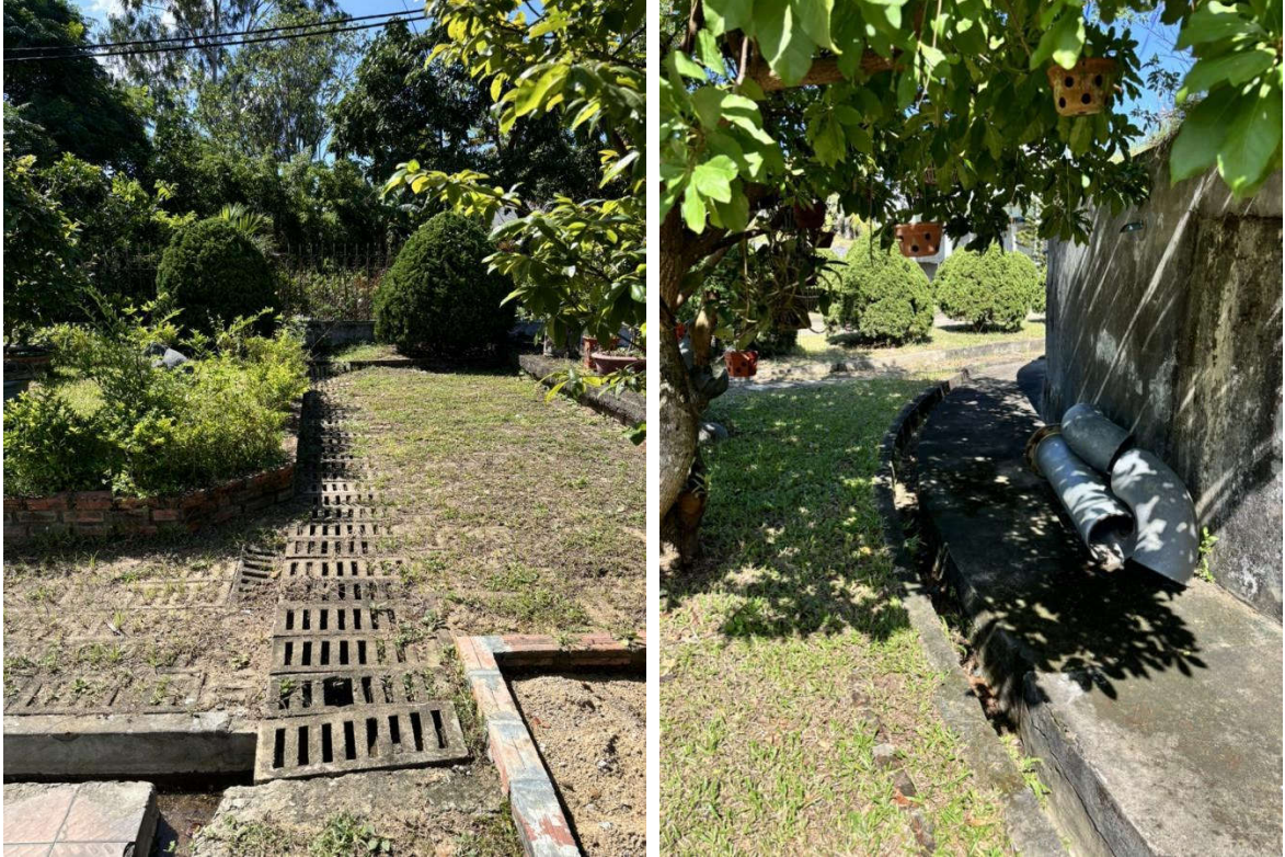
Hình 9: Hình ảnh mương thoát, rãnh thoát tại Nhà máy nước Hải Thành
