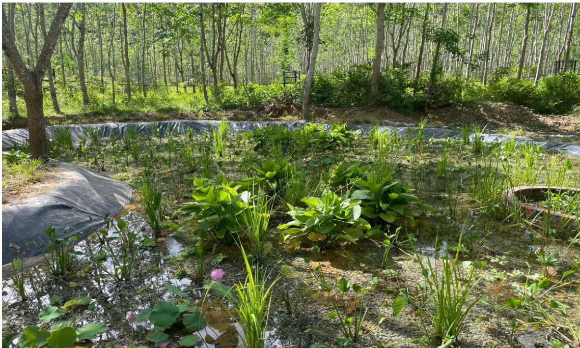
Hình 3.3: Bãi lọc ngầm đã thi công của dự án
