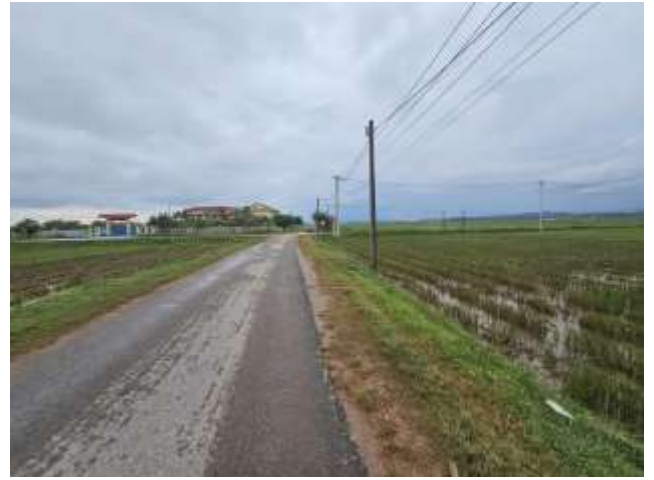
Hình ảnh đường 0.4kV
