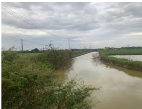
Hình ảnh cống thoát nước trên Quốc lộ 12A
