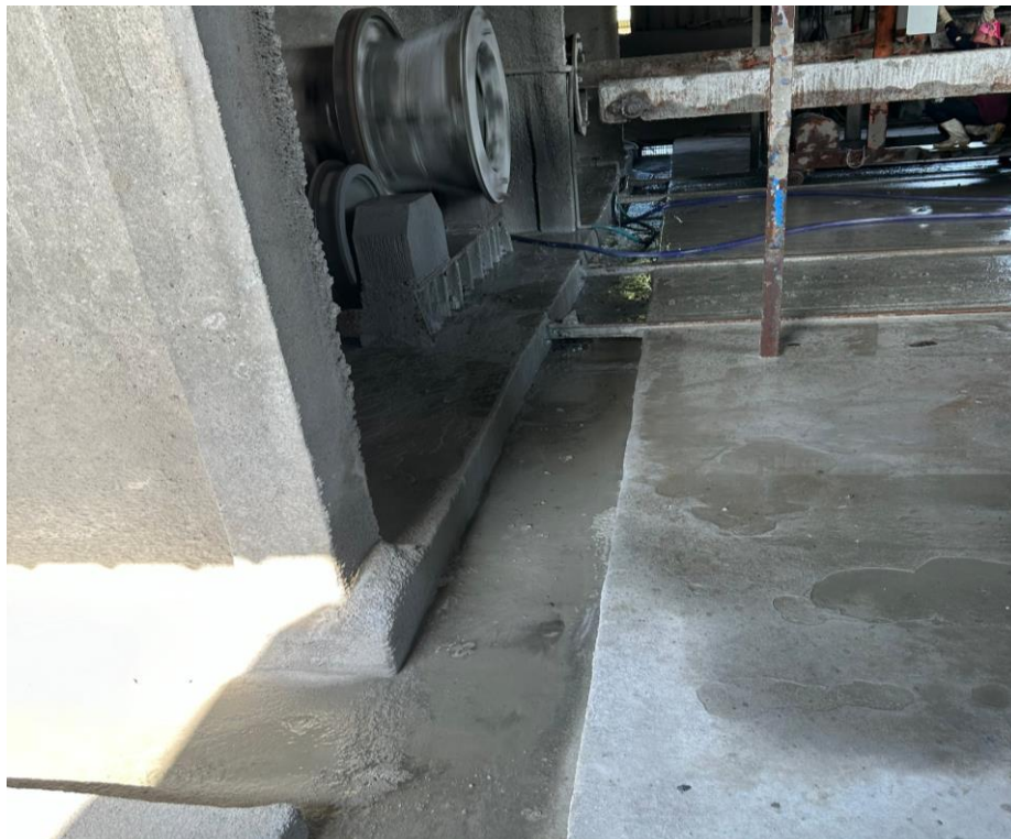
Hình 11. Mương BTXM thu nước thải tại khu vực bê tông ly tâm
