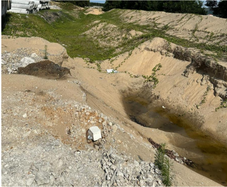
Hình 8. Tuyến mương thoát nước phía Tây cơ sở
