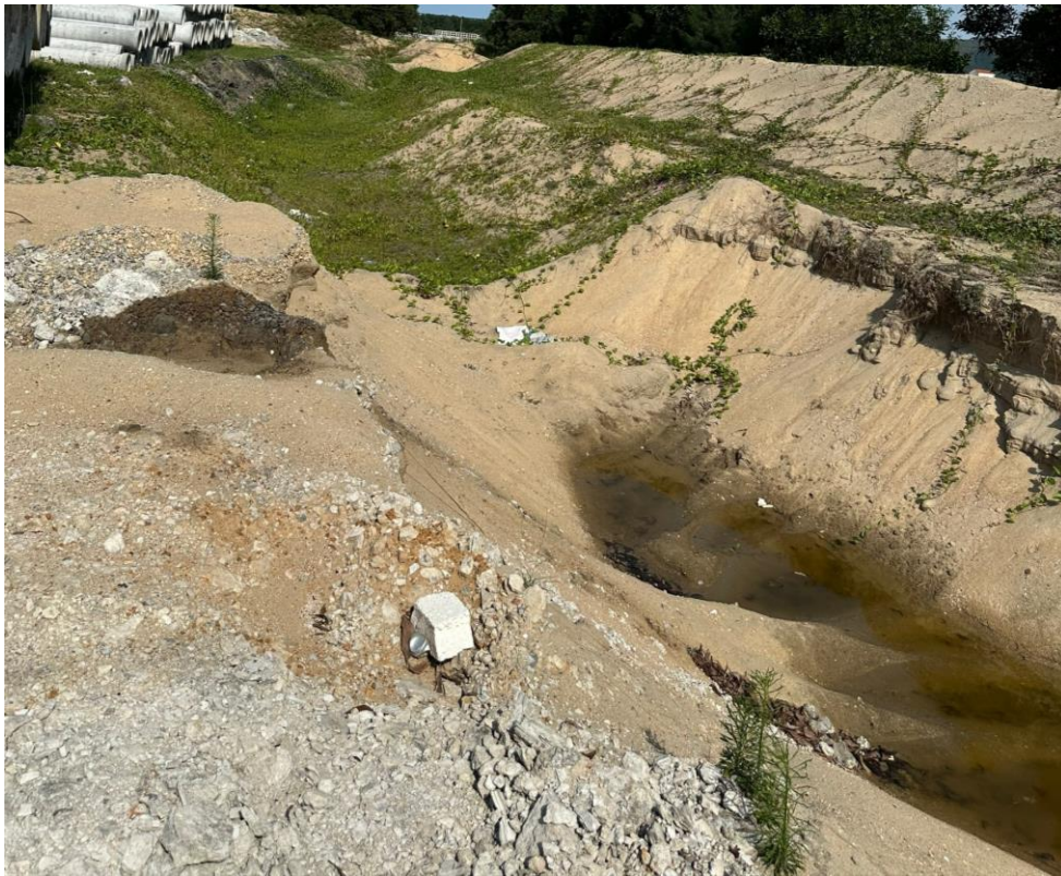
Hình 8. Tuyến mương thu nước phía Tây cơ sở
