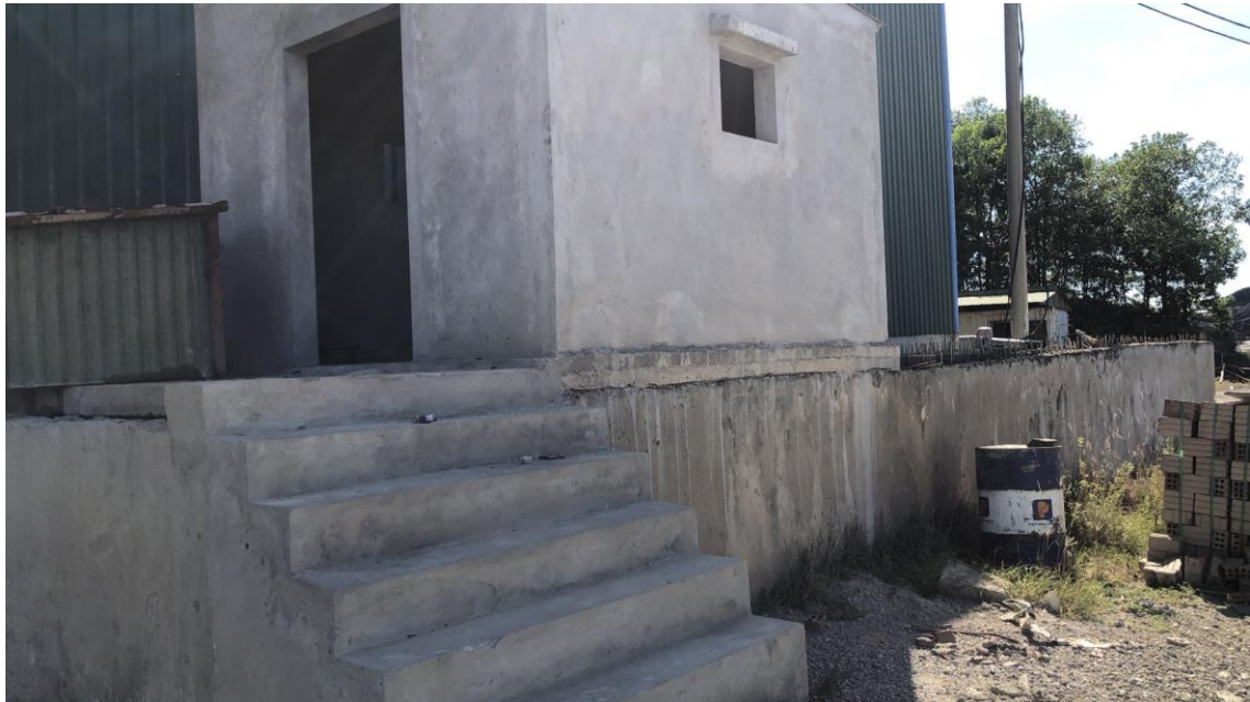
Hình 24. Hình ảnh bể chứa nước cứu hỏa của cơ sở
