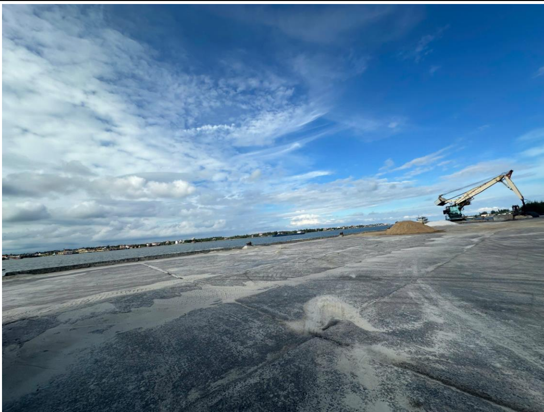
Hình 5. Hiện trạng cầu cảng
