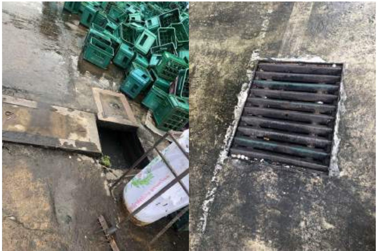
Hình 10. Hồ ga thu gom nước thải sản xuất
