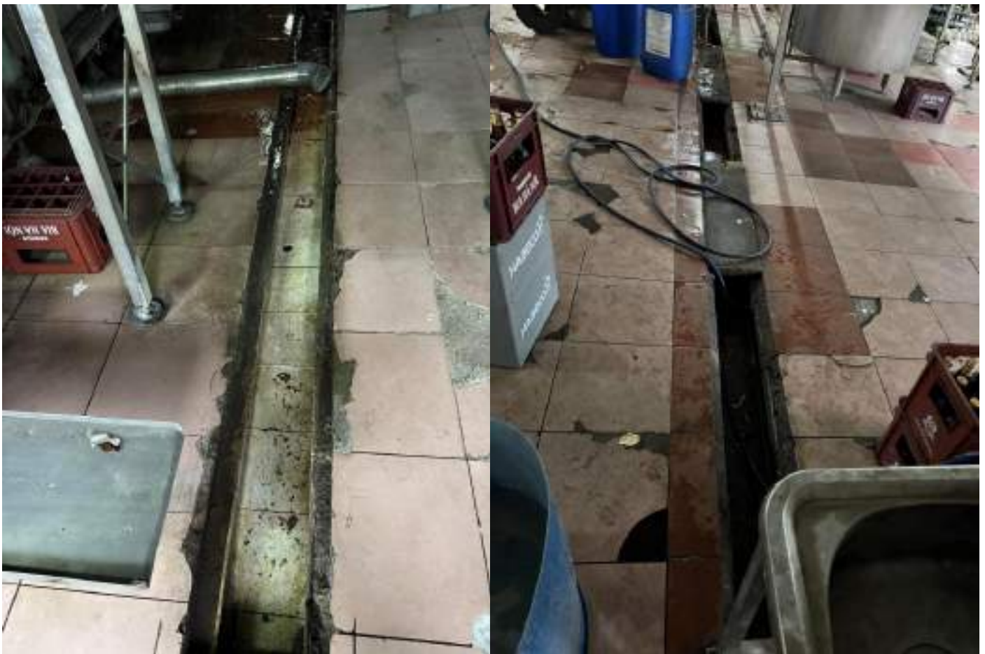
Hình 9. Hệ thống mương thu gom nước thải sản xuất
