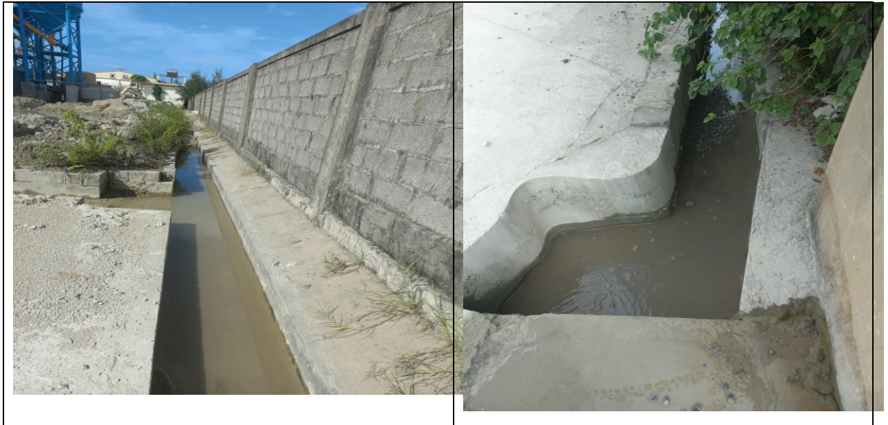
Mương thu gom nước mưa chảy tràn của nhà máy
