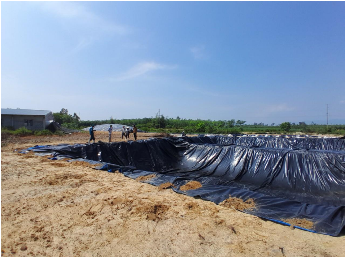
Hình 3.1: Thi công hệ thống xử lý nước thải
