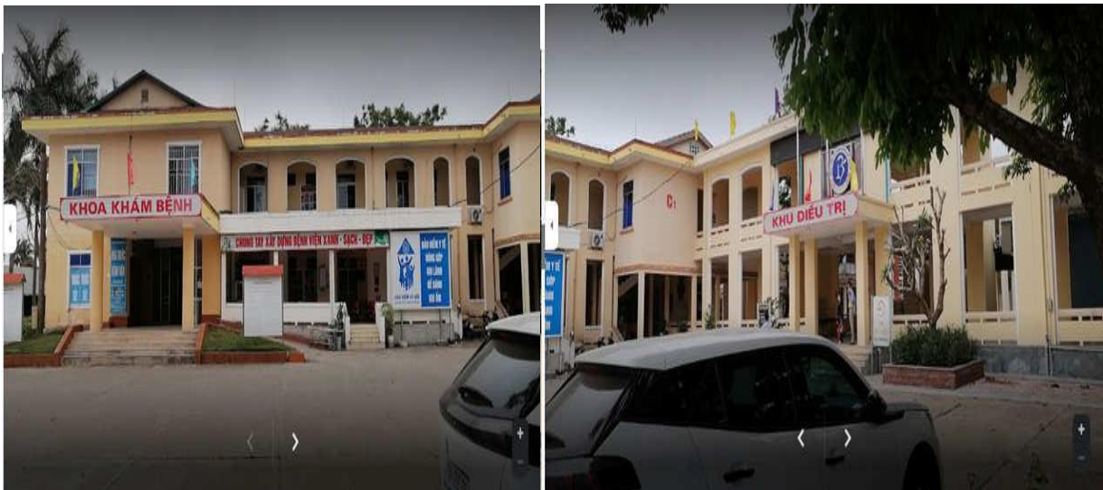
Hình 4: Hiện trạng khu Nhà kỹ thuật 2 tầng của Bệnh viện
