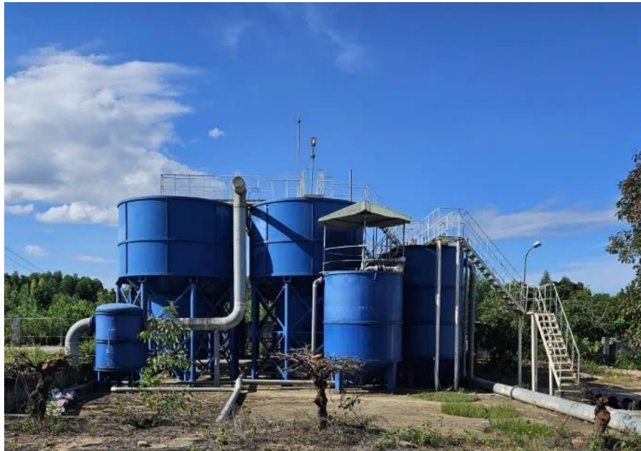
Hình 2: Cụm thiết bị lắng lọc liên tục 10.000 m 3 /ngày đêm
