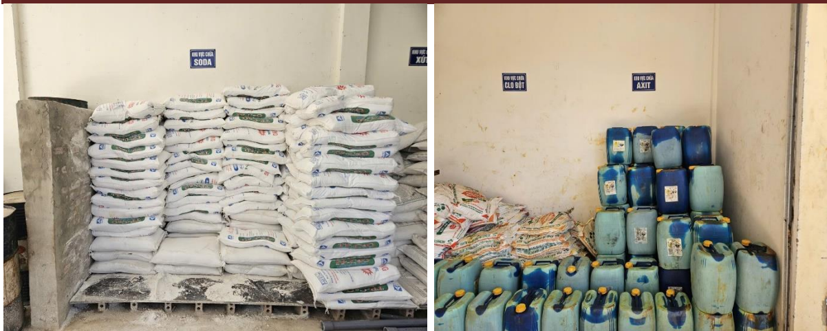
Hình 15: Kho hoá chất tại Nhà máy nước Phú Vinh
