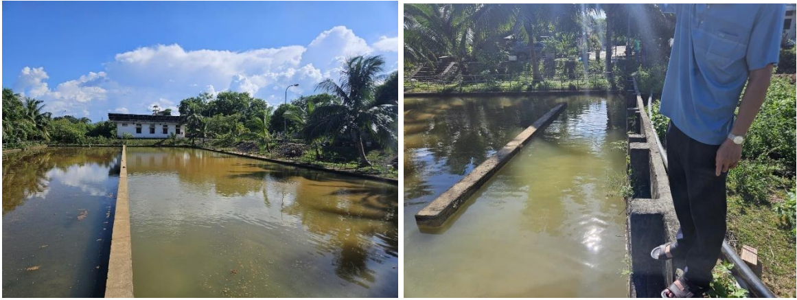
Hình 10: Bể lắng bùn của nhà máy nước Phú Vinh
