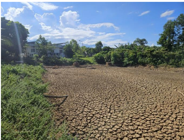
Hình 12: Bể phơi bùn
