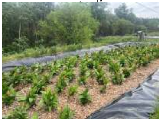
Bãi lọc ngầm
