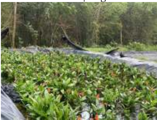
Bãi lọc ngầm
