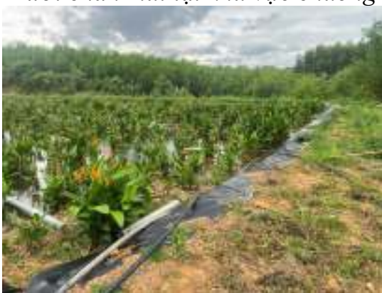
Bãi lọc ngầm
