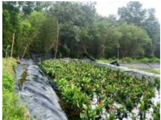
Bãi lọc ngầm
