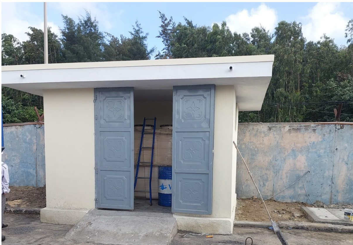
Hình 3.9: Nhà đặt bể xử lý nước thải sinh hoạt hợp khối
