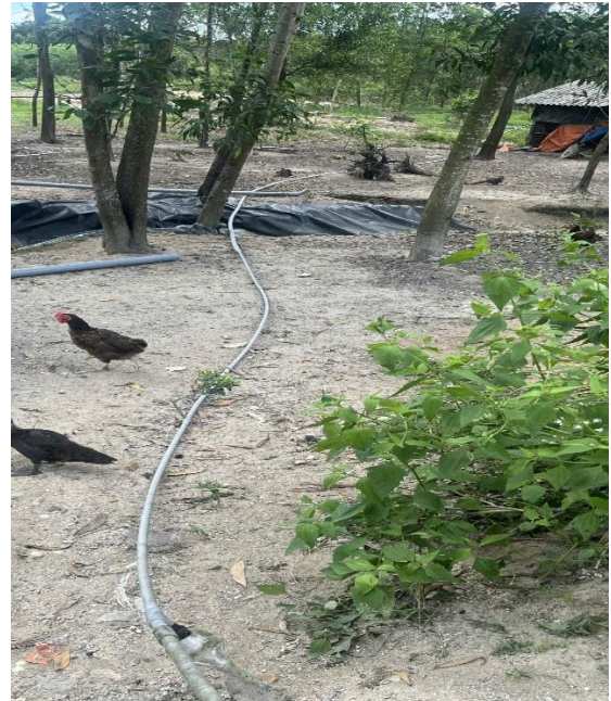
Hình 16: Đường dẫn khí và hệ thống cấp khí biogas cho đun nấu
