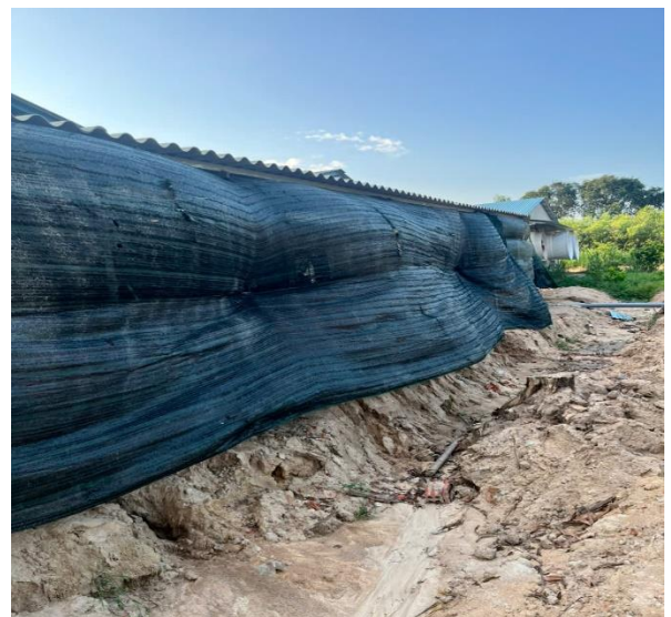
Hình 15: Hệ thống lưới ngăn mùi và pet phun sương phía sau quạt hút
