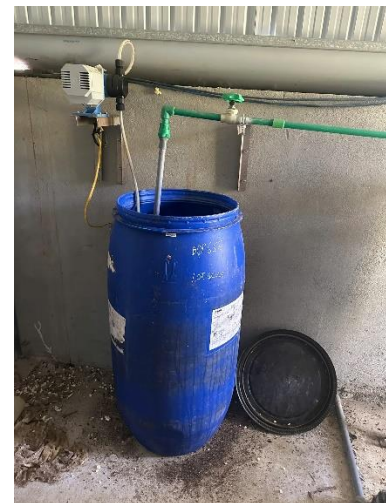
Hình 11: Thùng hoá chất và bơm định lượng
