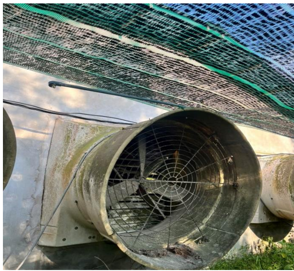
Hình 15: Hệ thống lưới ngăn mùi và pet phun sương phía sau quạt hút
