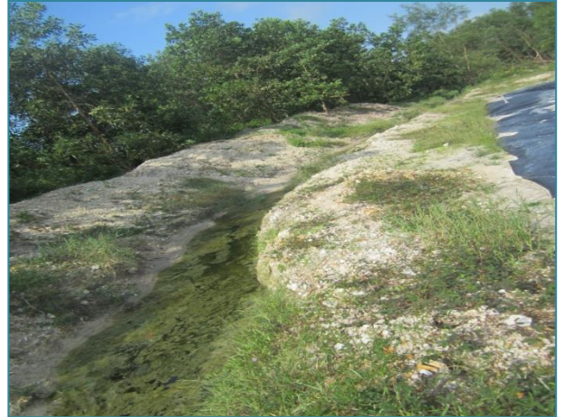
Rãnh đất thoát nước mưa
