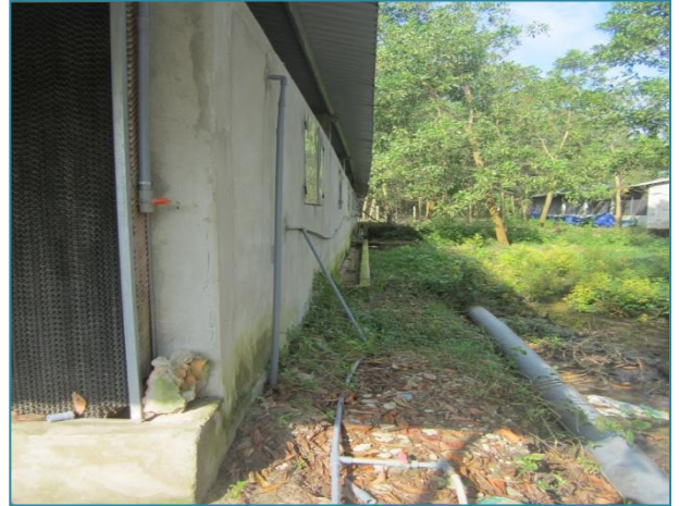
Ống nhựa D200 thu gom nước thải
