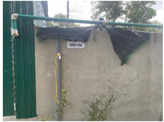
Hình 5: Bể điều hoà
