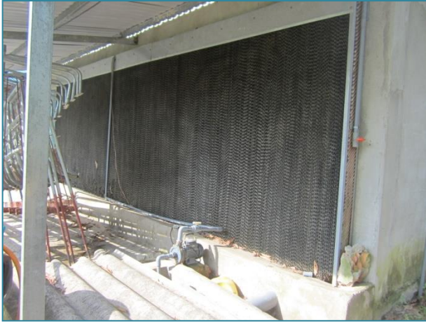
Hệ thống làm mát chuồng trại
