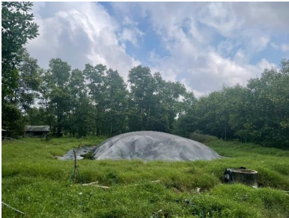
Hình 4: Hầm biogas
