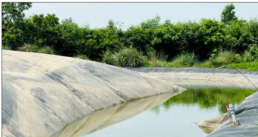
Van xả khí hầm biogas
