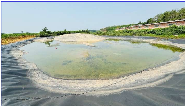
Hầm biogas - hồ sinh học (03 hồ nối tiếp nhau)
