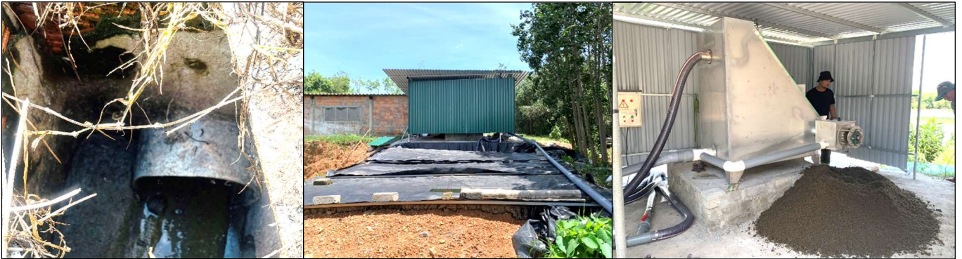
Hệ thống thu gom nước thải - Hồ gom - Nhà ép phân
