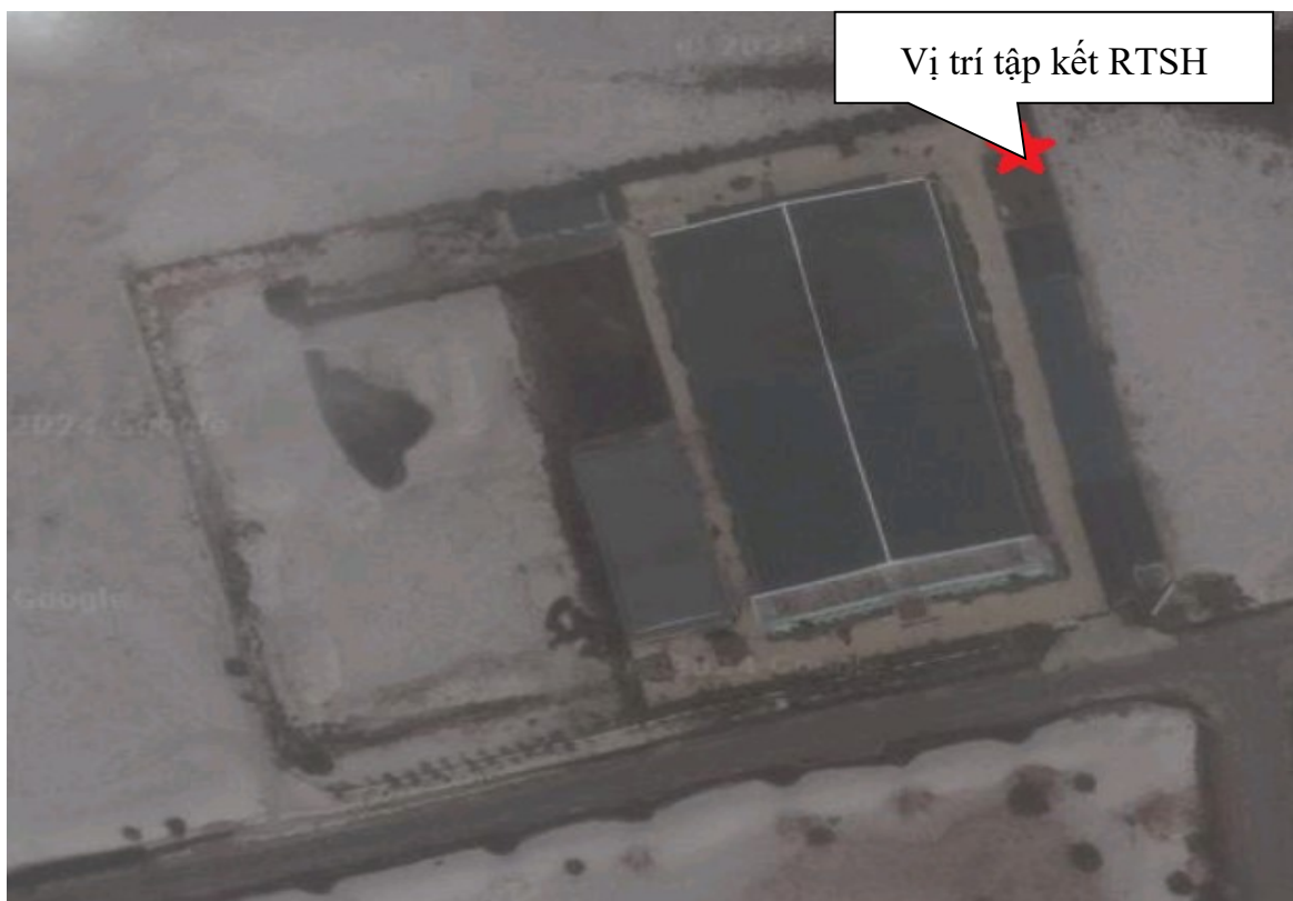
Hình 4: Vị trí bãi tập kết rác thải sinh hoạt của dự án
