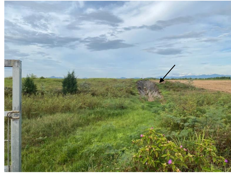
Hình ảnh: Tuyến mương thoát nước khu bay M1
