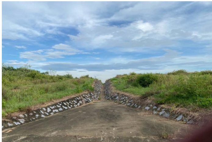
Hình ảnh: Tuyến mương thu nước khu bay M2
