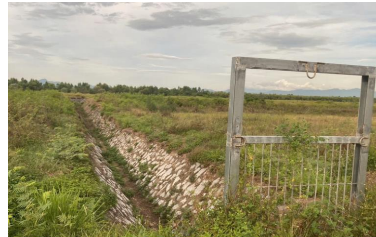
Hình ảnh: Tuyến mương thu nước khu bay M3
