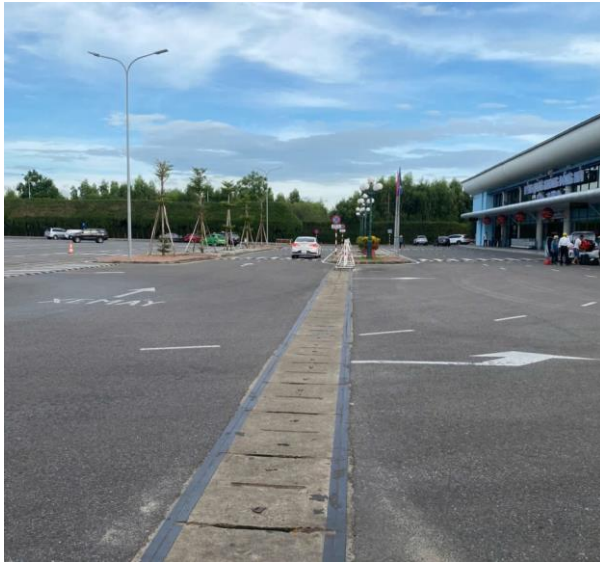
Hình ảnh: Tuyến mương thoát nước sân đường
