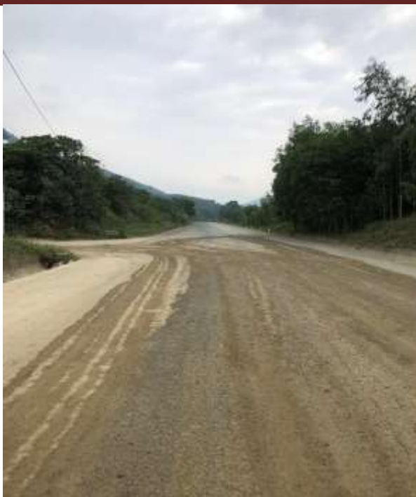
Hiện trạng Tuyến đường tỉnh lộ DT22
