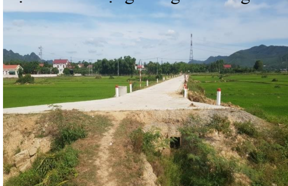
Tuyến đường tiếp giáp điểm đầu tuyến
