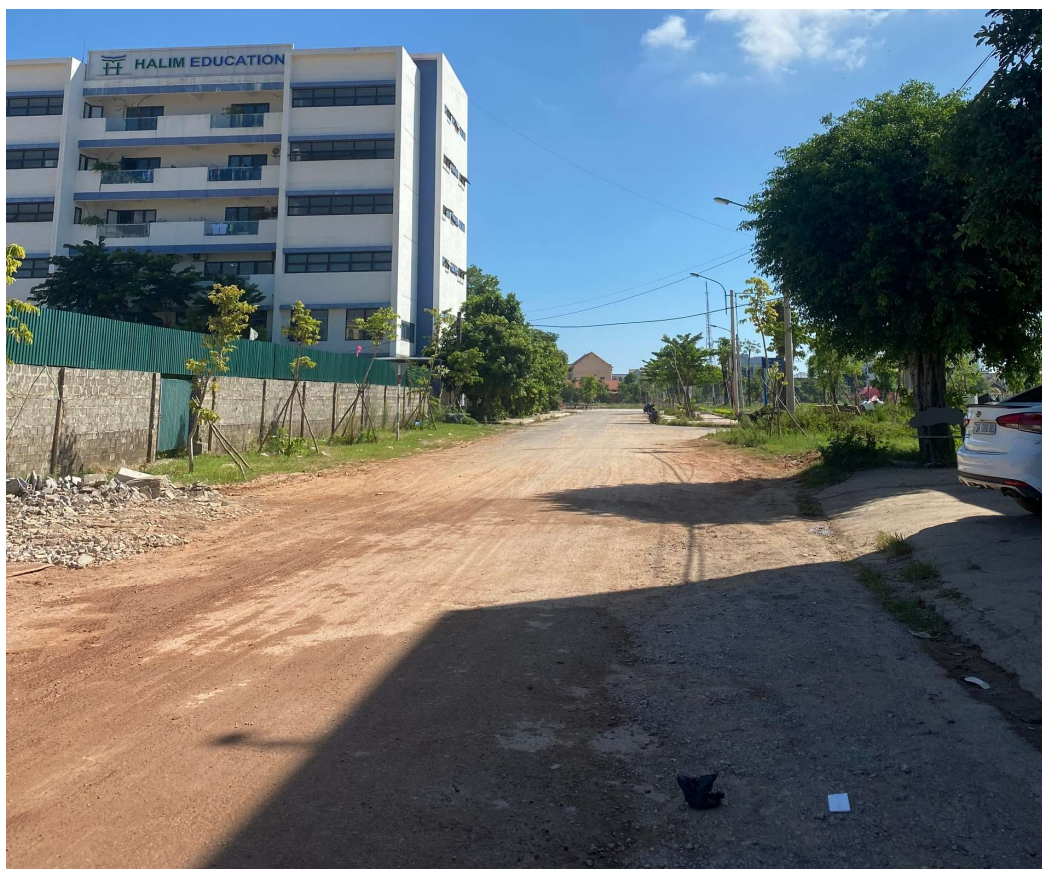
Hình 4. Hiện trạng tuyến đường phía Đông dự án
