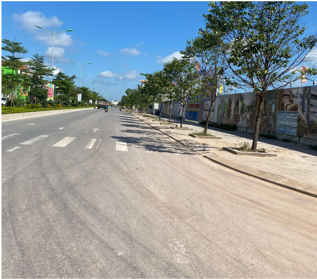
Hình 5. Hiện trạng tuyến đường Phạm Văn Đồng đoạn qua dự án
