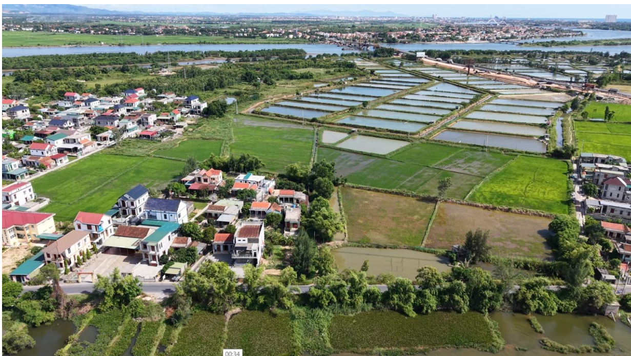
Hình 1.2. Tổng thể hiện trạng khu vực Dự án
