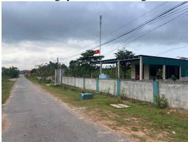
Hình 1.3: Hiện trạng khu dân cư phía Nam dự án
