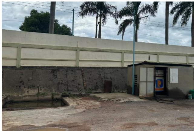
Hình 19. Hiện trạng trạm xăng dầu nội bộ và bể lắng dầu
