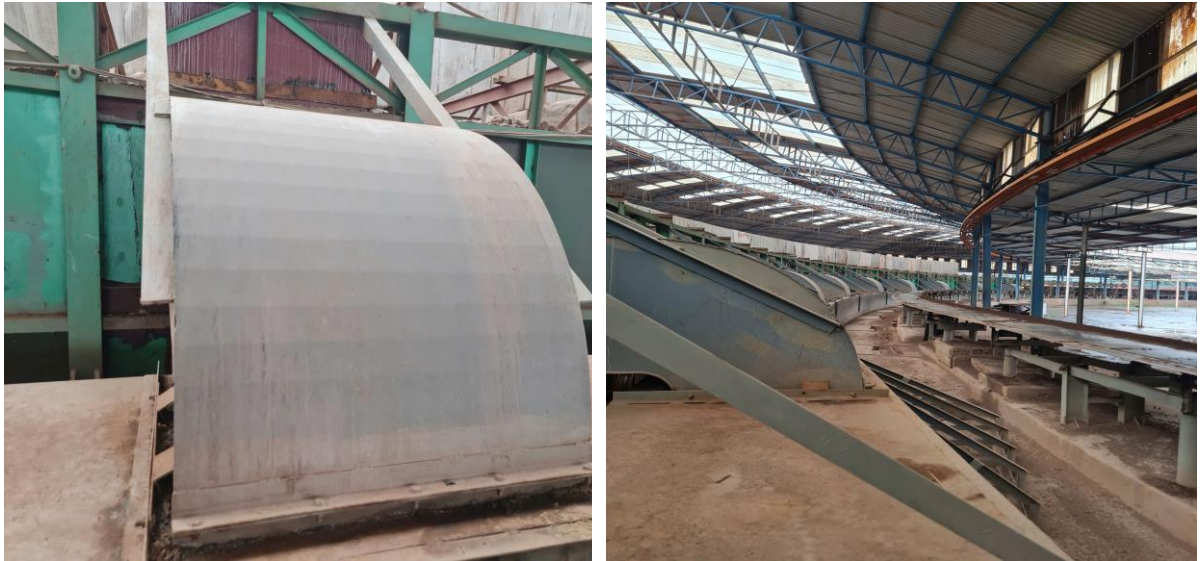
Hình 24. Bộ phận chụp hút khí thải
