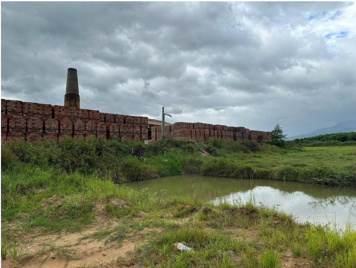
Hình 15. Hồ điều hòa phía Đông Bắc xí nghiệp
