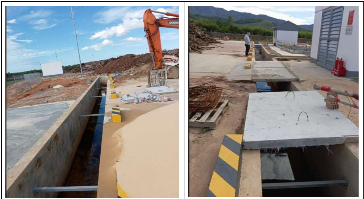
Hình 3.1: Mương thoát nước mưa phía Bắc dự án
