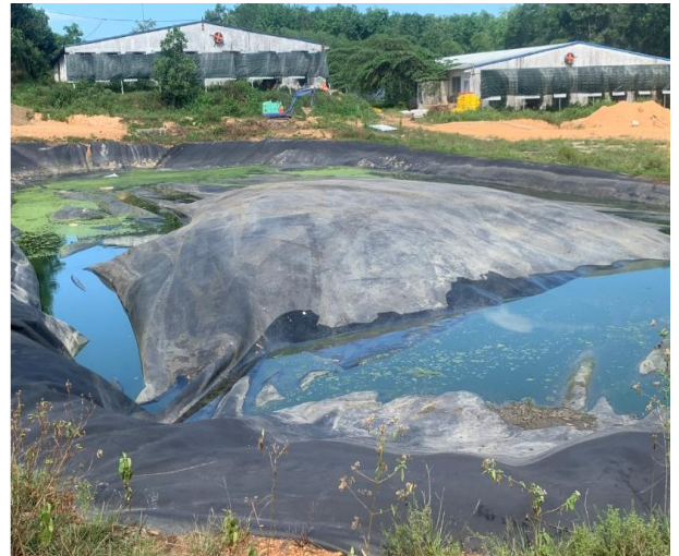
Hồ biogas cũ đang sử dụng
