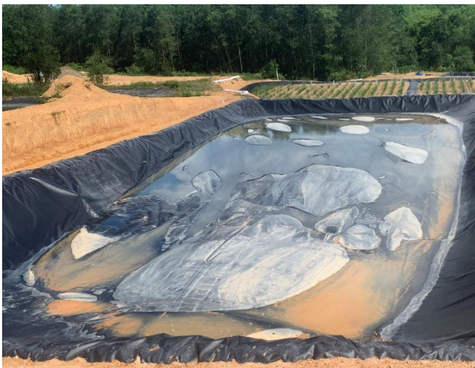
Hồ biogas cũ tận dụng làm hồ lắng
