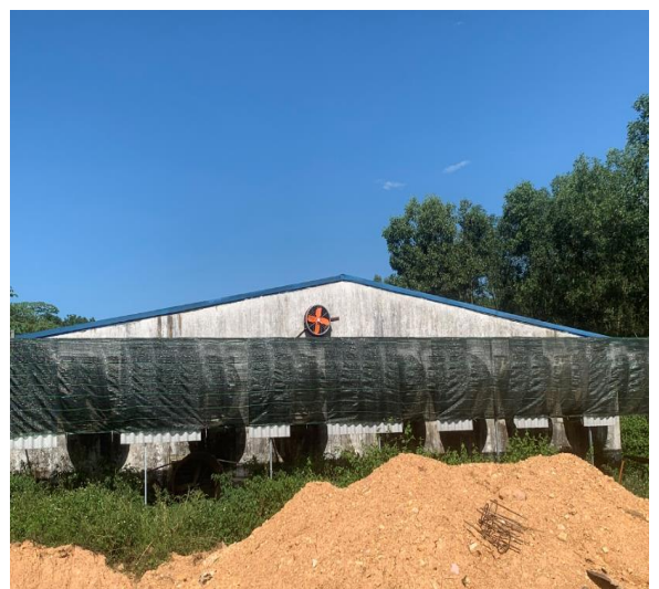
Lắp đặt lưới giảm thiểu mùi
