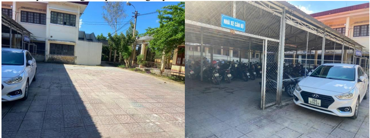
Hình 1.4. Hiện trạng khu đất chuẩn bị đầu tư xây mới Khối nhà điều trị Sản, Ngoại, Liên khoa
