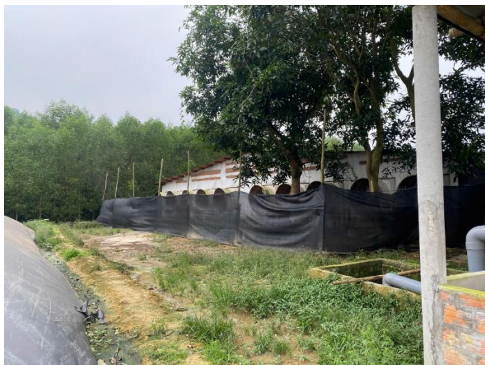
Hình 20. Hệ thống lưới ngăn mùi và PET phun chế phẩm EM sau quạt hút
