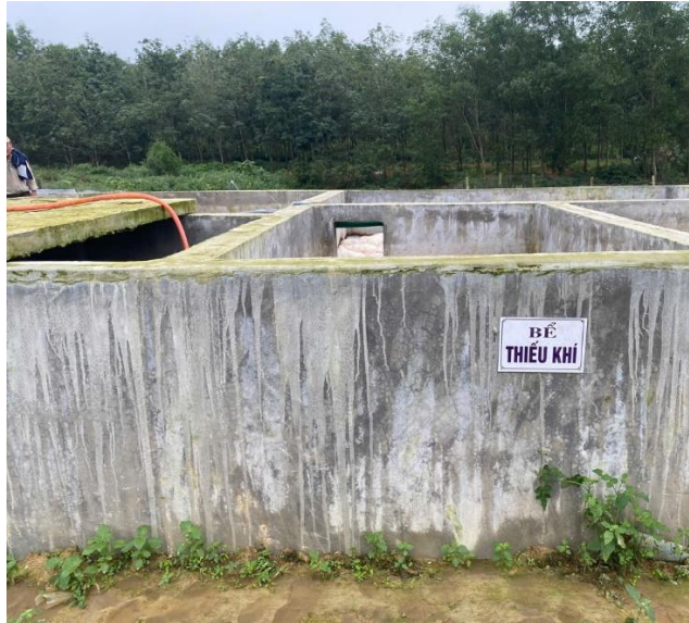
Hình 13. Bể thiếu khí 1
