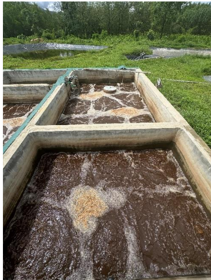
Hình 15. Bể thiếu khí 2
