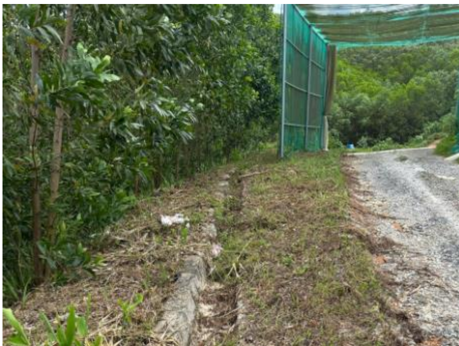
Hình 5. Tuyến thoát nước mưa ở dãy chuồng phía bắc
