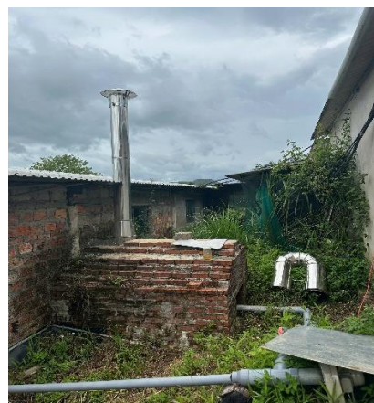
Hình 21. Đường ống dẫn khí và lò đốt khí biogas
