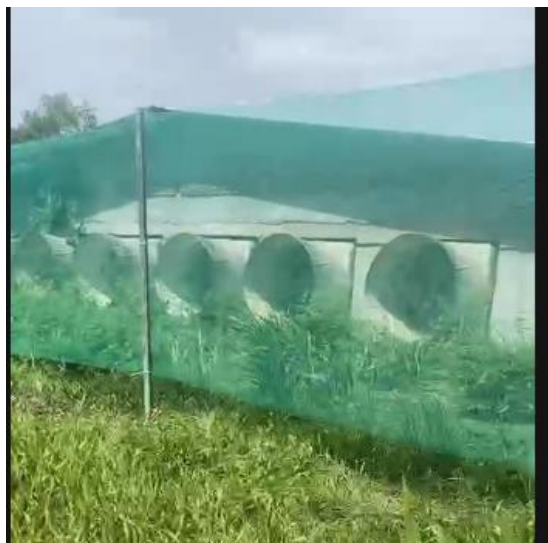
Hình 20. Hệ thống lưới ngăn mùi và PET phun chế phẩm EM sau quạt hút
