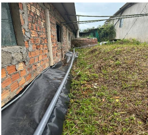
Hình 21. Đường ống dẫn khí và lò đốt khí biogas
