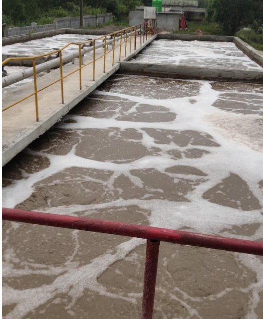
Hình 3.10. Bể hiếu khí
