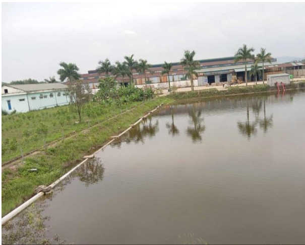
Hình 3.14. Hồ nước PCCC
