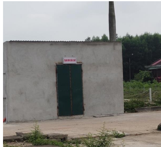
Hình 3.15. Trạm bơm PCCC
